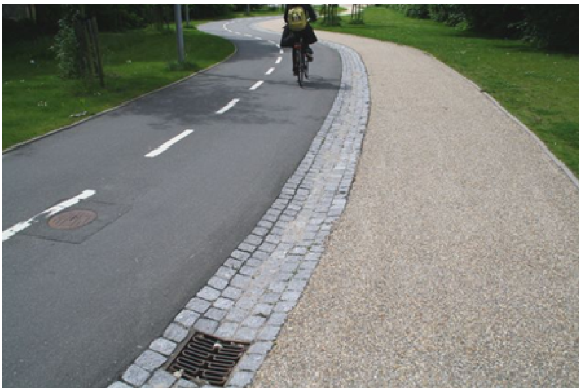
Možný spôsob oddelenia cyklistickej a pešej prevádzky (Foto: Ing. Květoslav Syrový - Kodaň) Odvodňovací prúžok slúži súčasne ako hmatný pás
