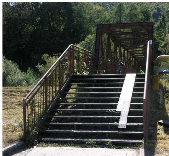
Lávka cez Hron v Majeri – neúplné lyžiny bez proti-šmykovej úpravy
