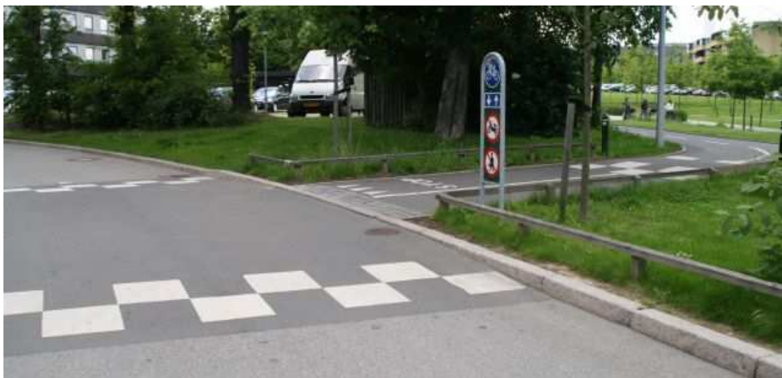
Ukážka nájazdu do pridruženého priestoru cez stavebný prah (Foto: Ing. Květoslav Syrový - Kodaň). Opatrenie funguje súčasne ako ukludnenie v krížení a súčasne ako nájazd z priečných smerov.
